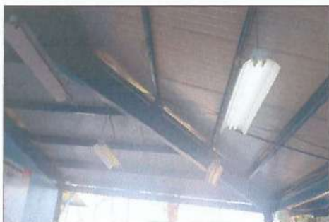
Foto 7: REPARACIÓN DE SISTEMA ELÉCTRICO
