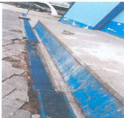
Foto 3: CUNETA DE CONCRETO
