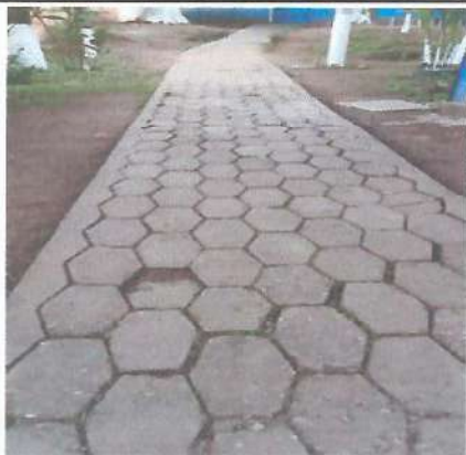
Foto 5: LOSA DE PATIO
